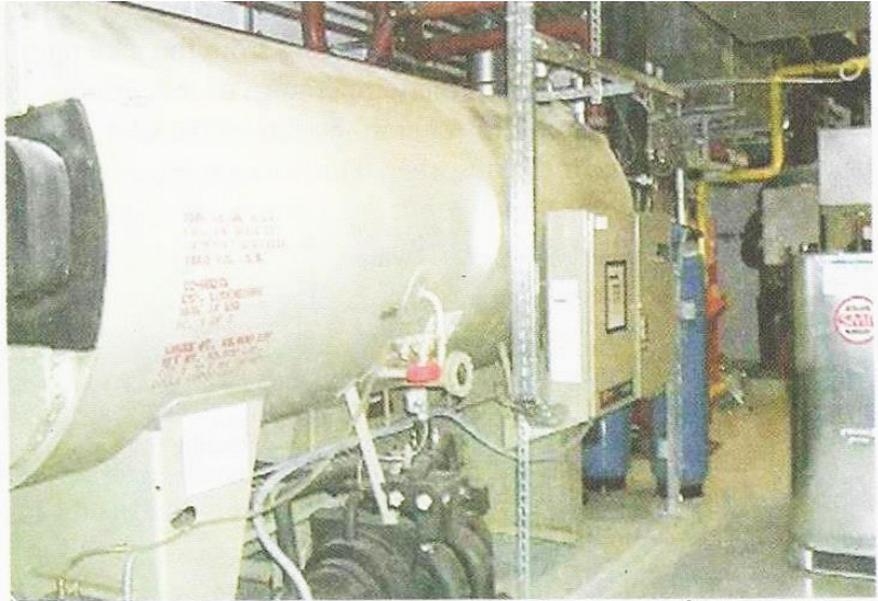
Simple vapour absorption machine.
